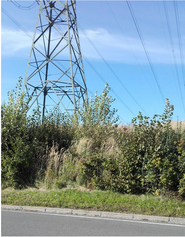
vedení VVN na hraně ulice Borovského
