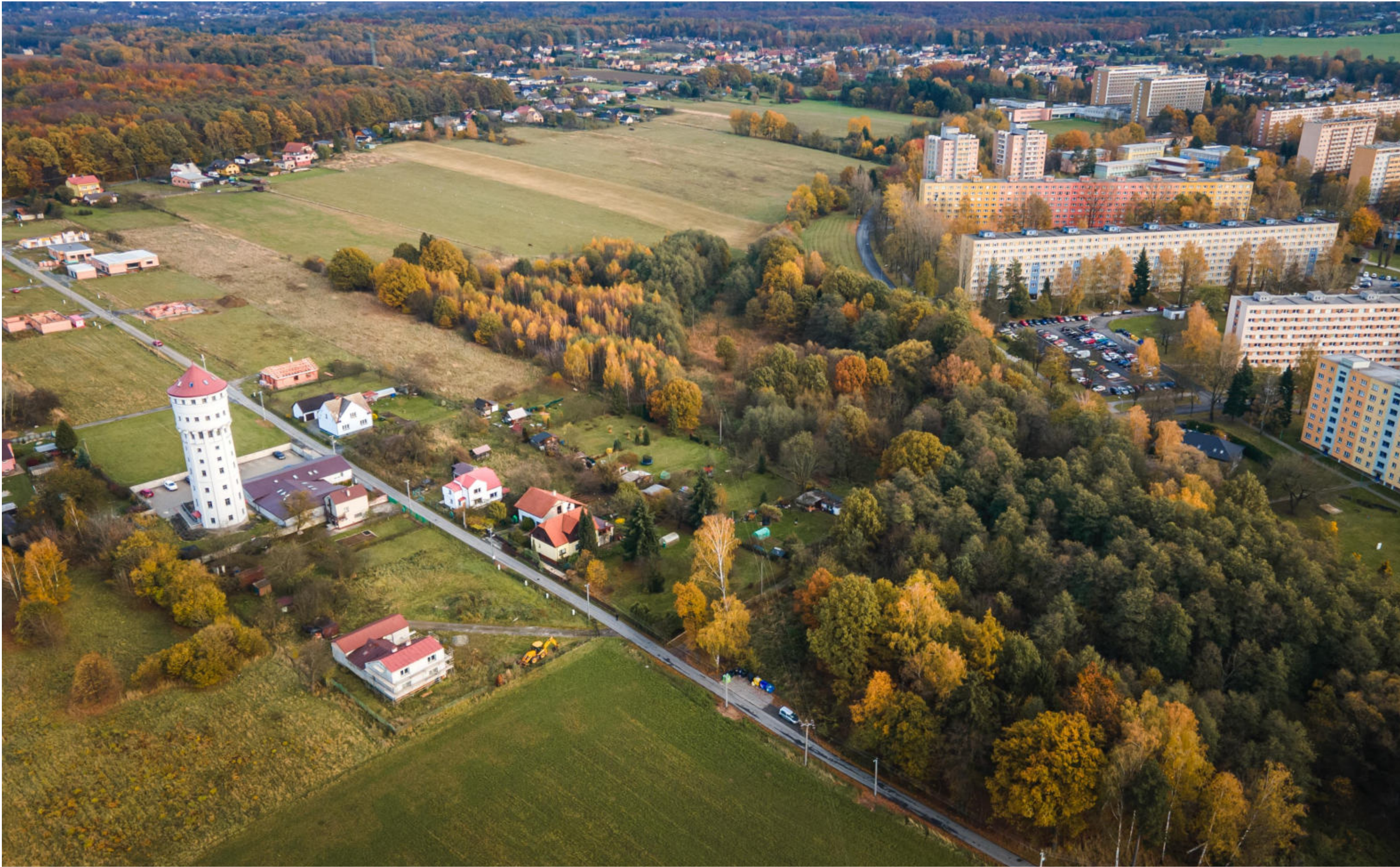
19 celkový pohled na řešené území
