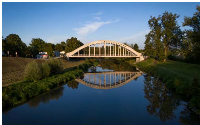
MOST SOKOLOVSKÝCH HRDINŮ DOSTANE PO OČIŠTĚNÍ IMPREGNAČNÍ NÁTĚR
