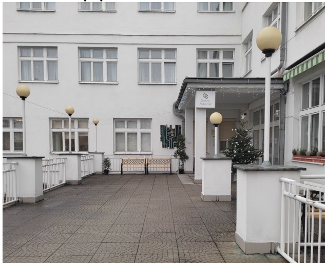
Detail vstupu do budovy
